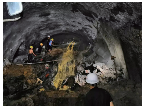
图1 开挖、治理中的砂土隧道照片
